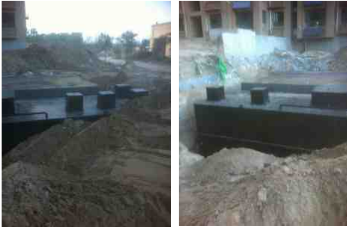
图 4-4 中水处理回用设施照片
